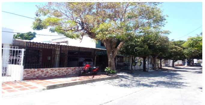
Fachada del Inmueble
