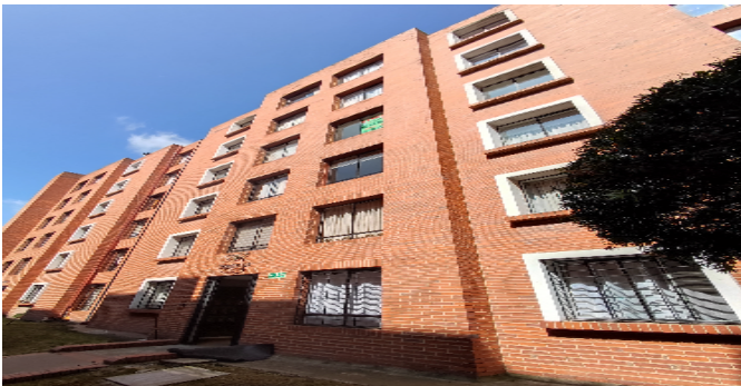
Fachada del Inmueble
