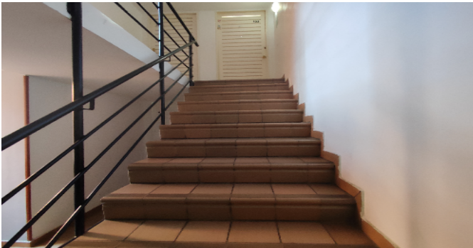
Escalera común - CJ
