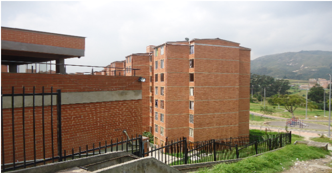
Fachada del Inmueble
