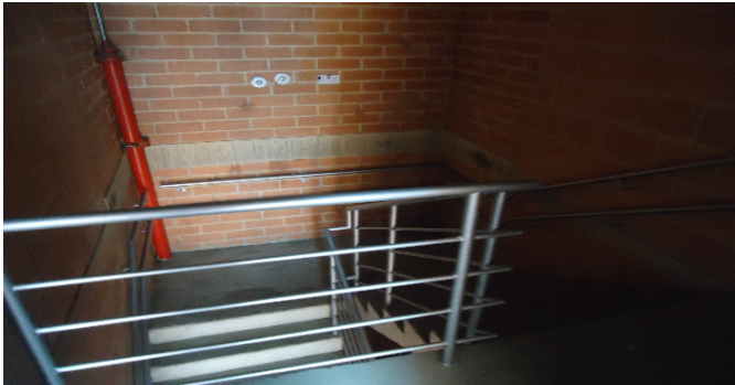
Escalera común - CJ
