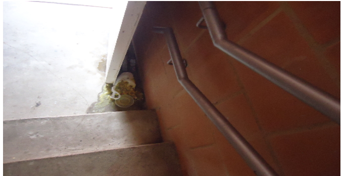
Escalera común - CJ
