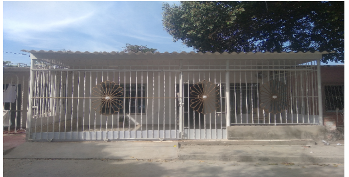
Fachada del Inmueble
