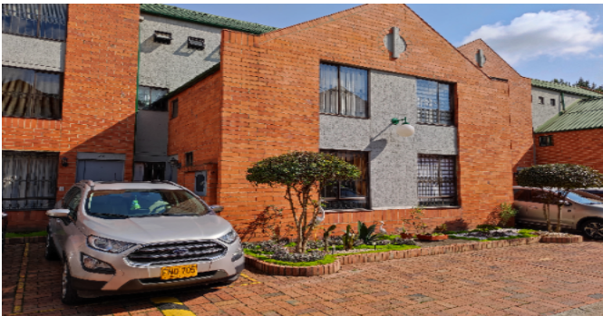
Fachada del Inmueble
