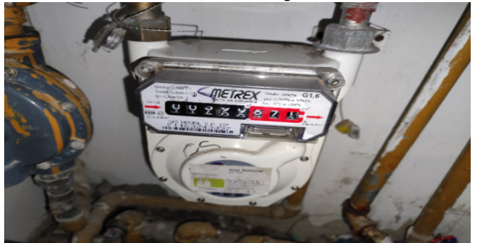
Contador de Agua
