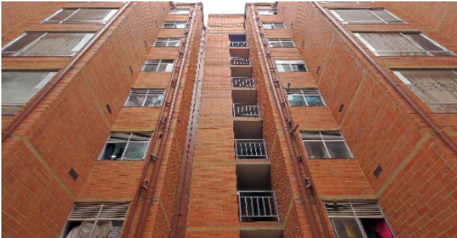
Fachada del Inmueble
