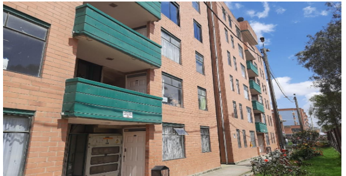
Fachada del Inmueble
