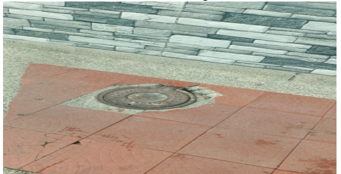
Contador de Agua
