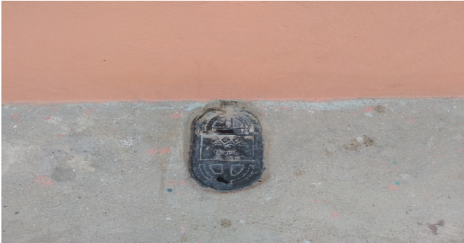
Contador de Agua
