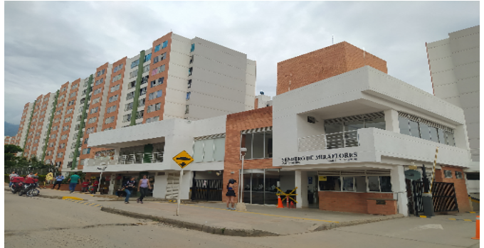
Fachada del Inmueble
