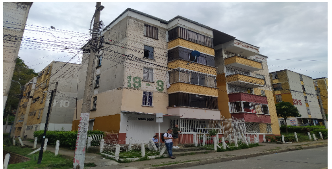
Fachada del Inmueble
