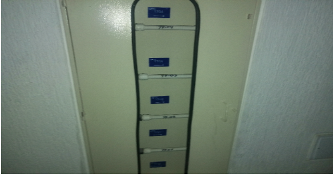
Contador de Agua
