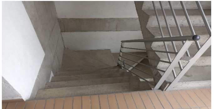
Escalera común - CJ
