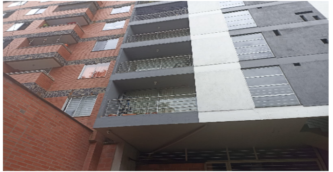
Fachada del Inmueble
