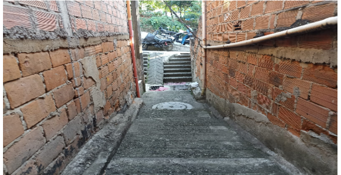
Escalera común - CJ
