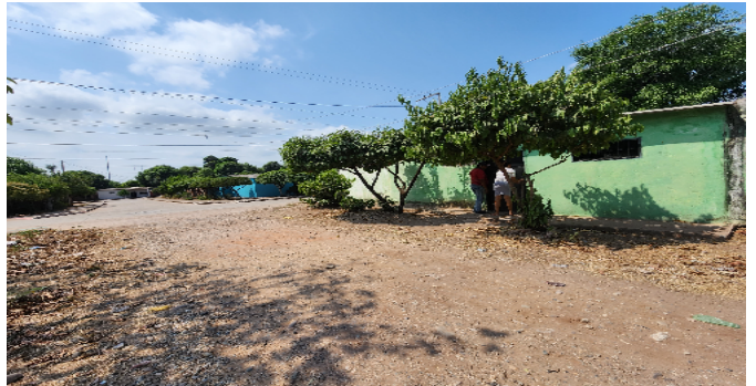
Fachada del Inmueble
