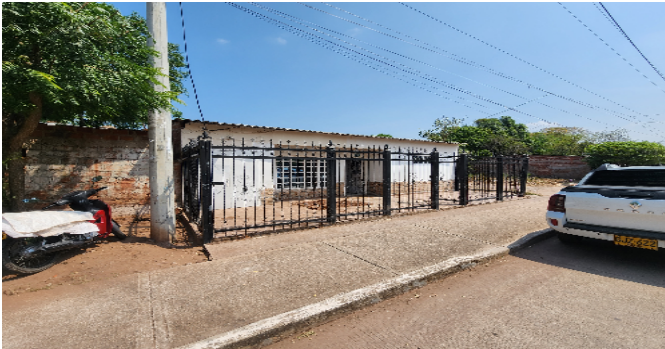
Fachada del Inmueble
