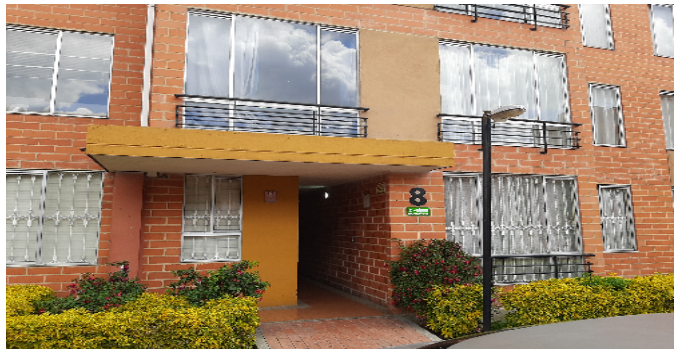
Fachada del Inmueble
