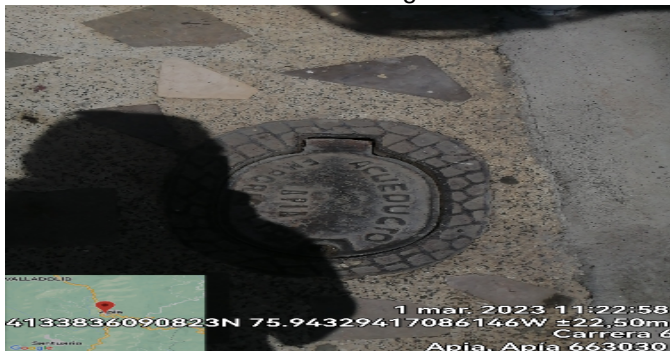
Contador de Agua
