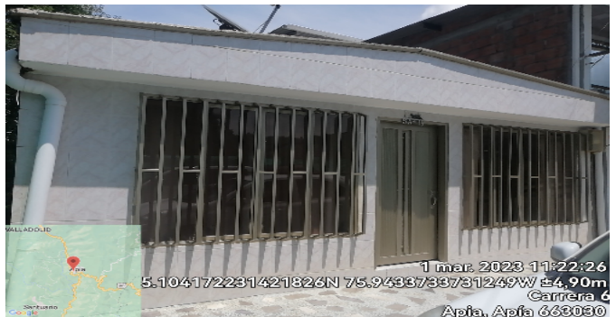
Fachada del Inmueble
