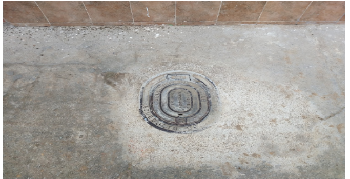
Contador de Agua
