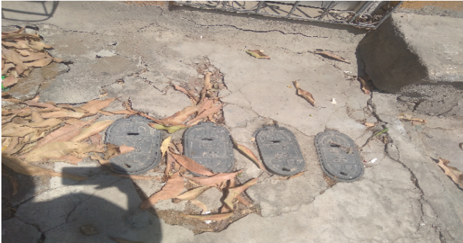
Contador de Agua
