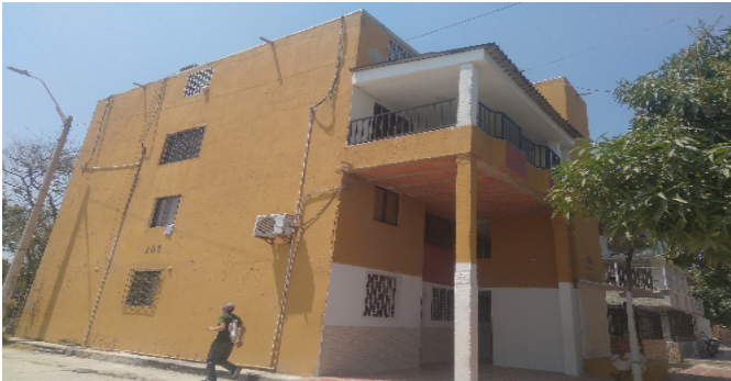
Fachada del Inmueble
