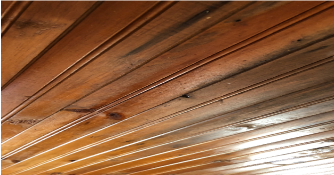
Detalle de acabados
