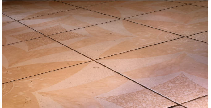
Detalle de acabados
