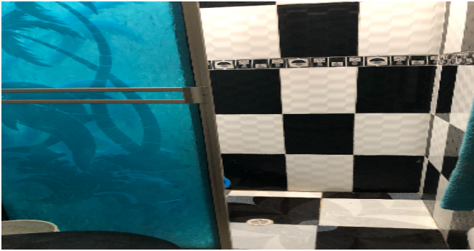
Detalle de acabados
