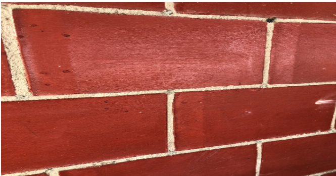
Detalle de acabados
