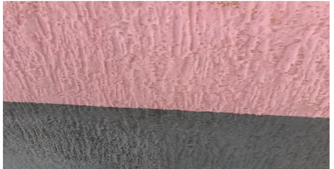
Detalle de acabados
