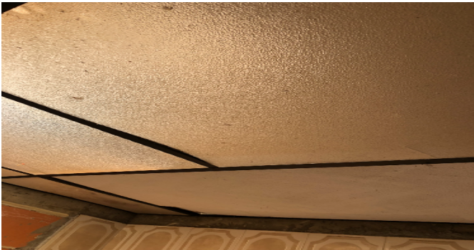
Detalle de acabados
