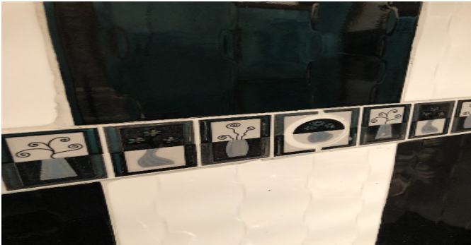
Detalle de acabados
