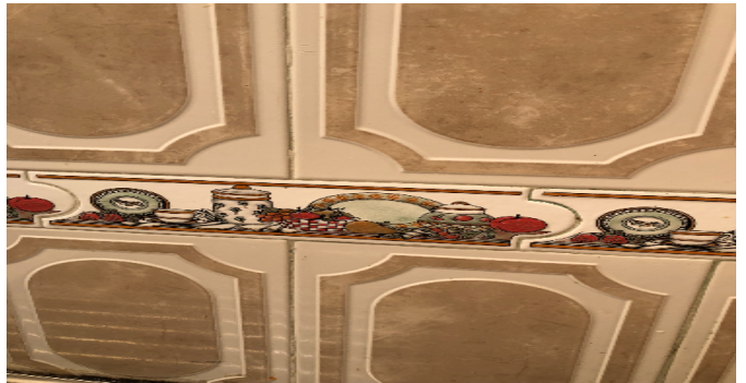
Detalle de acabados
