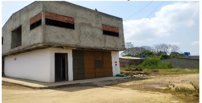
Contador de Energia
