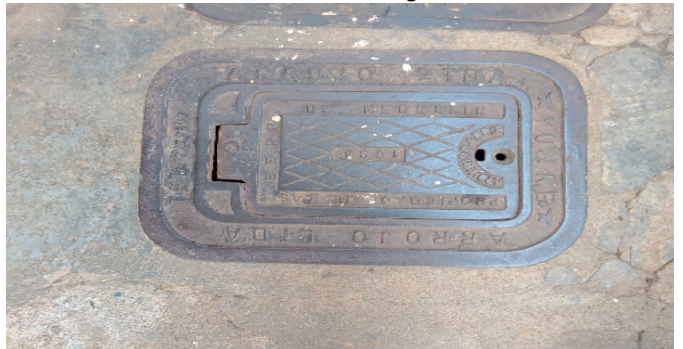
Contador de Agua
