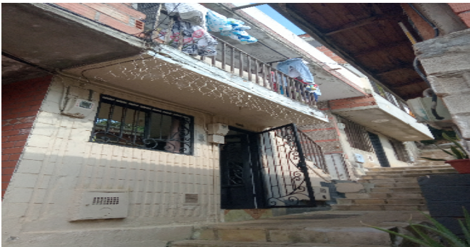
Fachada del Inmueble
