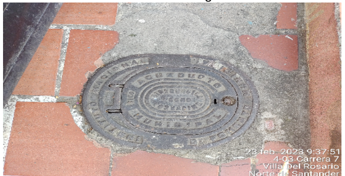
Contador de Agua
