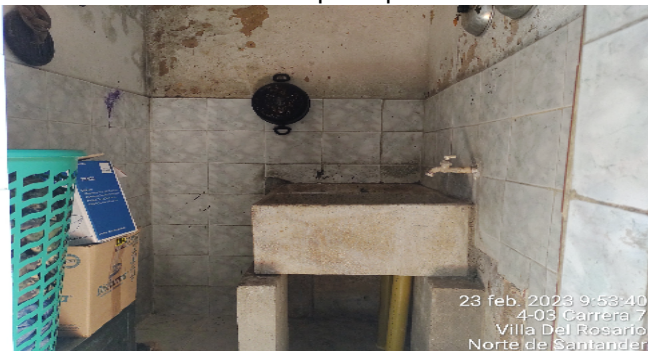
Zona de ropas Apto 2
