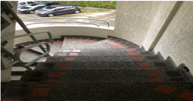
Escalera común - CJ
