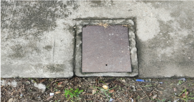
Contador de Agua
