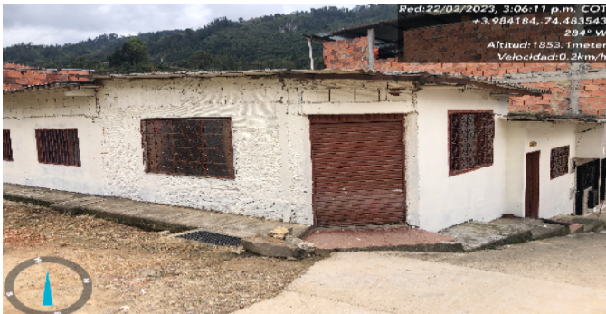
Fachada del Inmueble
