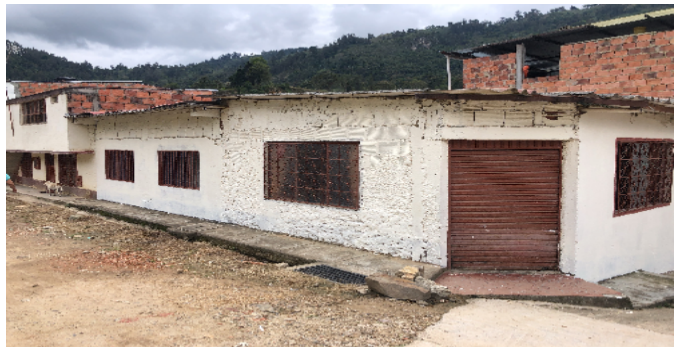
Fachada del Inmueble
