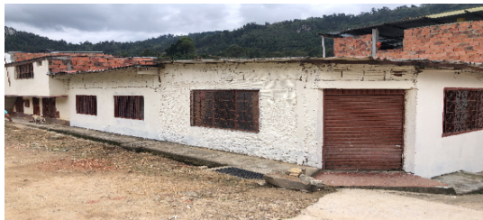
Fachada del Inmueble
