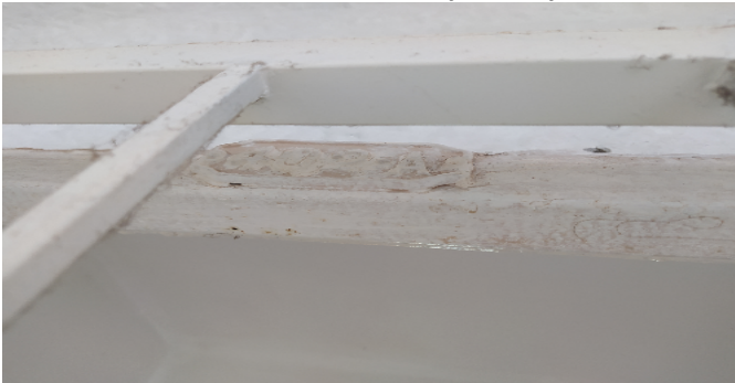
Nomenclatura Inmueble y/o Conjunto
