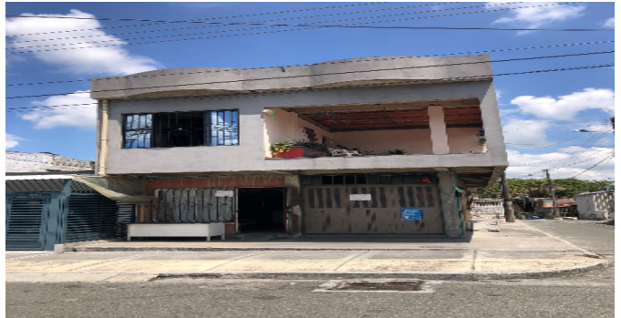
Fachada del Inmueble
