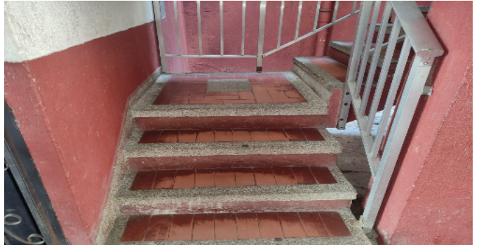
Escalera común - CJ
