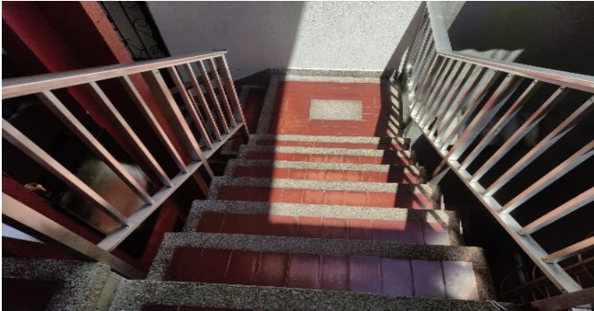
Escalera común - CJ
