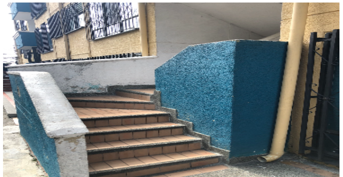
Escalera común - CJ
