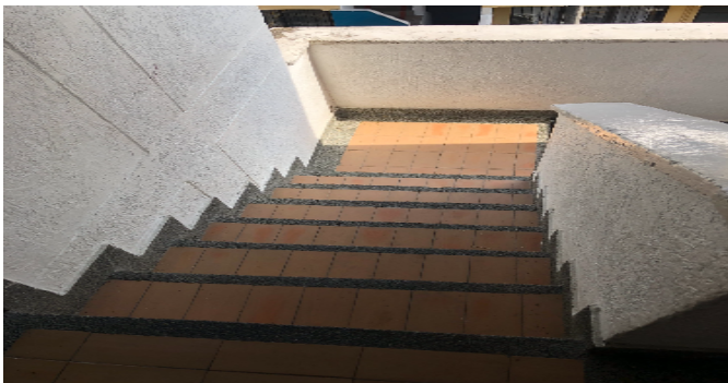
Escalera común - CJ
