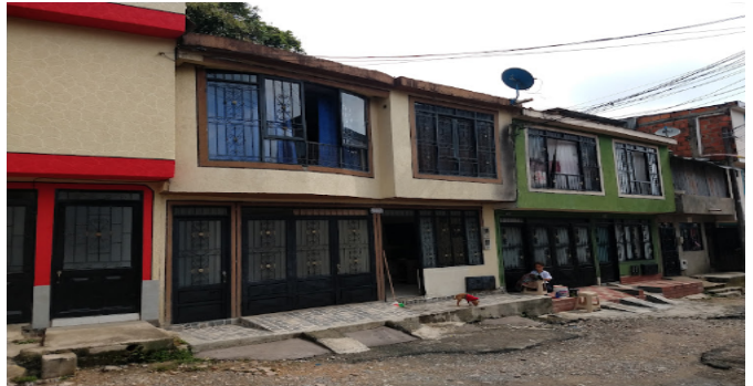
Fachada del Inmueble
