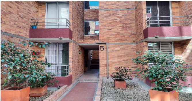
Entrada a la torre
