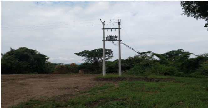
Contador de Energia
