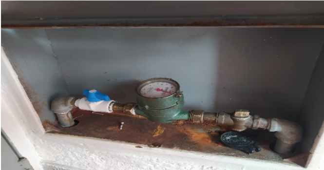
Contador de Agua
