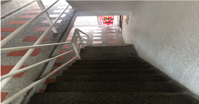
Escalera común - CJ
