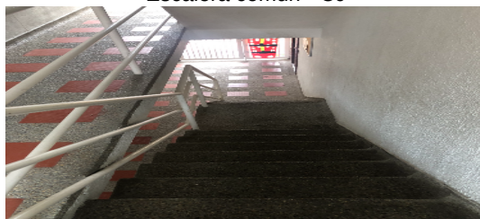
Escalera común - CJ
