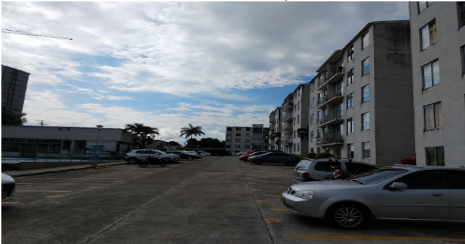
Fachada del Conjunto
