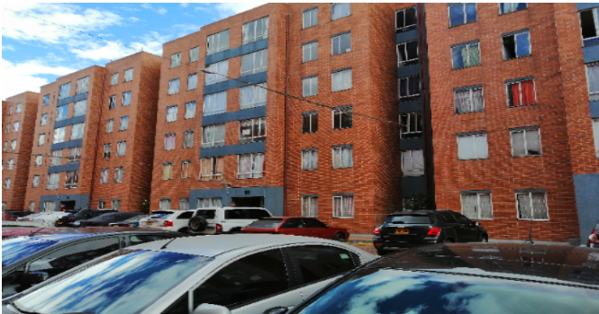
Fachada del Inmueble
