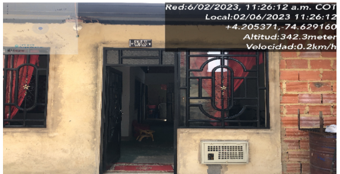
Contador de Gas
