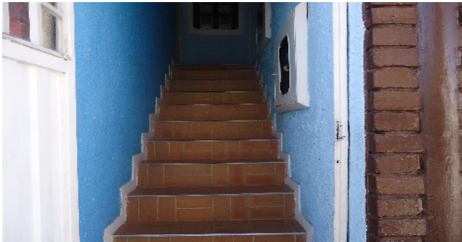
Escalera común - CJ
