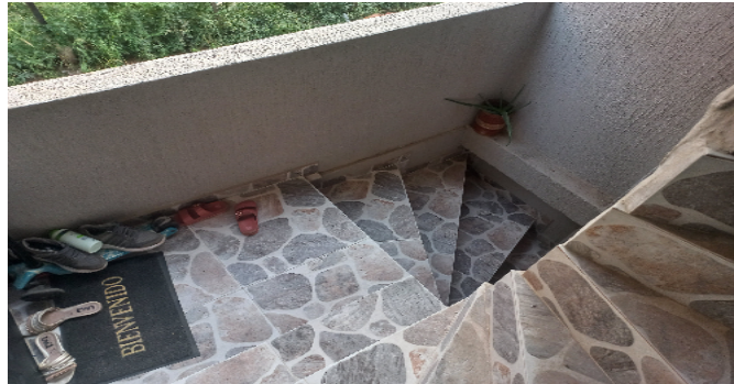
Escalera común - CJ
