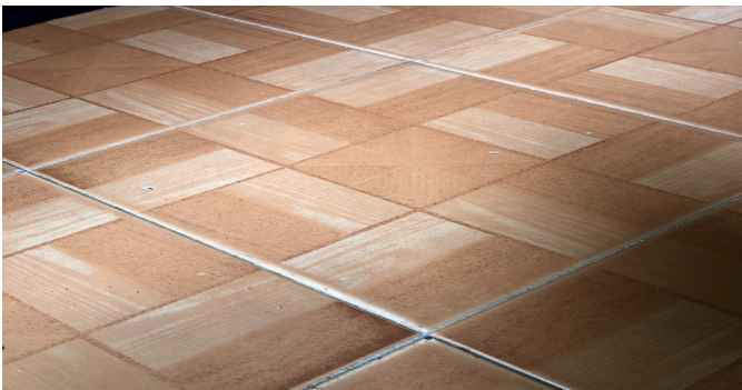
Detalle de acabados
