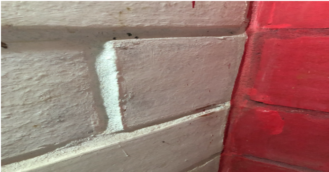
Detalle de acabados
