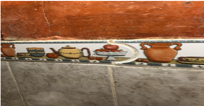
Detalle de acabados
