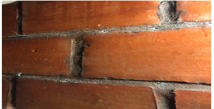
Detalle de acabados
