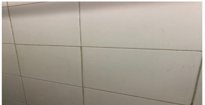
Detalle de acabados
