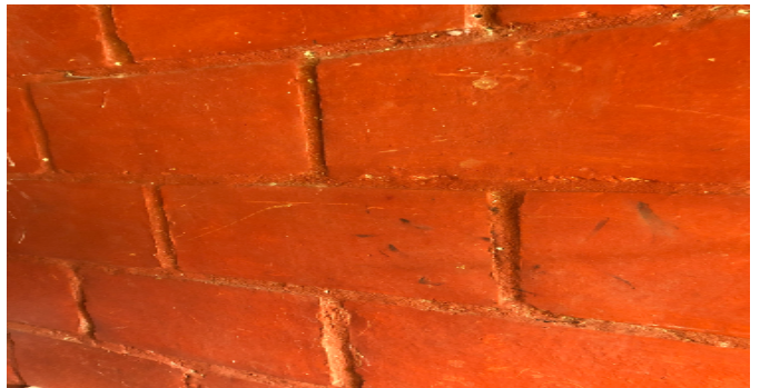
Detalle de acabados
