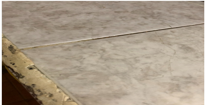
Detalle de acabados
