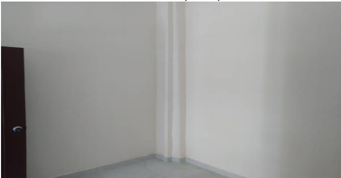
Puerta Hab. principal
