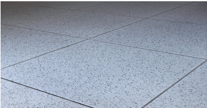
Detalle de acabados
