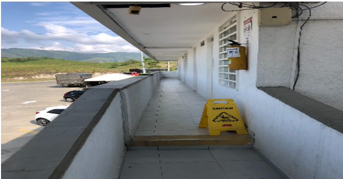
Corredor Piso 2 - Hotel
