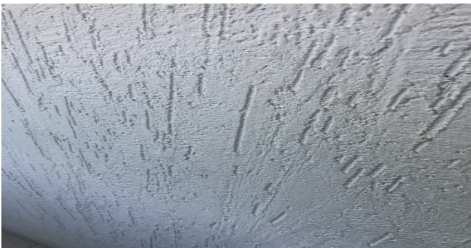
Detalle de acabados
