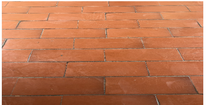
Detalle de acabados
