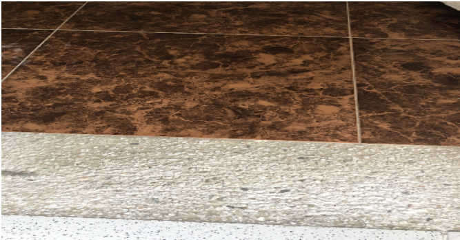
Detalle de acabados
