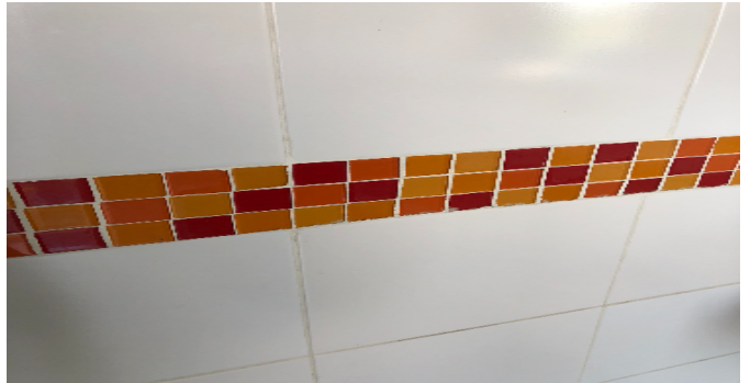
Detalle de acabados
