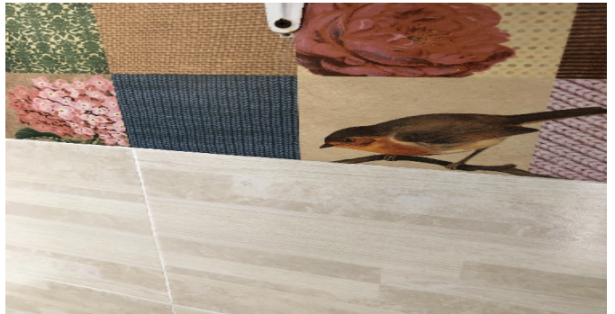
Detalle de acabados
