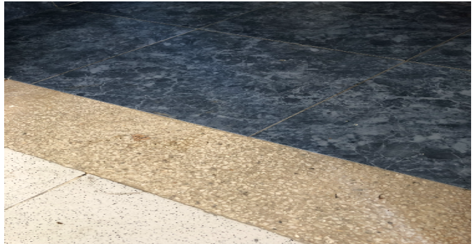
Detalle de acabados
