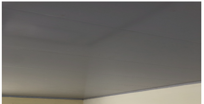
Detalle de acabados
