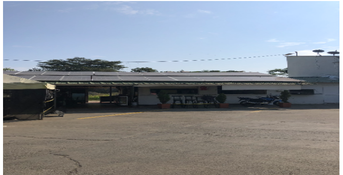
Fachada del Inmueble
