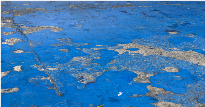
Detalle de acabados
