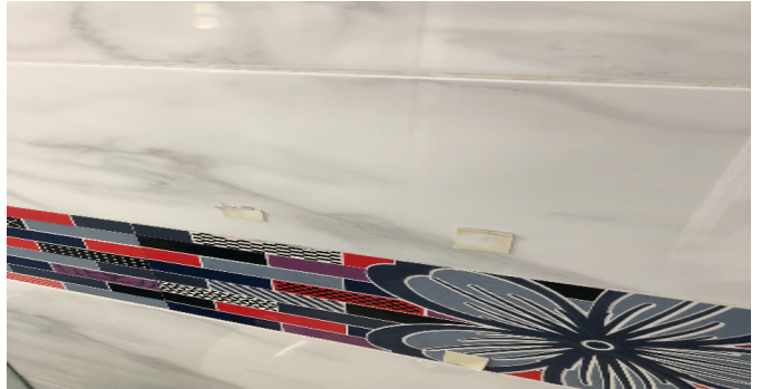
Detalle de acabados
