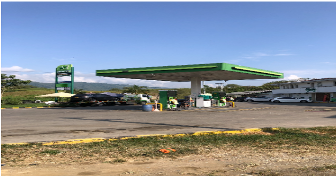
Fachada del Inmueble
