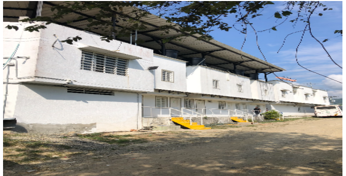
Fachada del Inmueble
