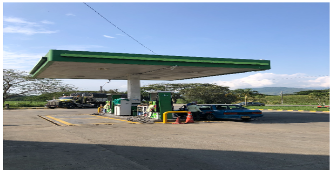
Fachada Estaci3n Servicio
