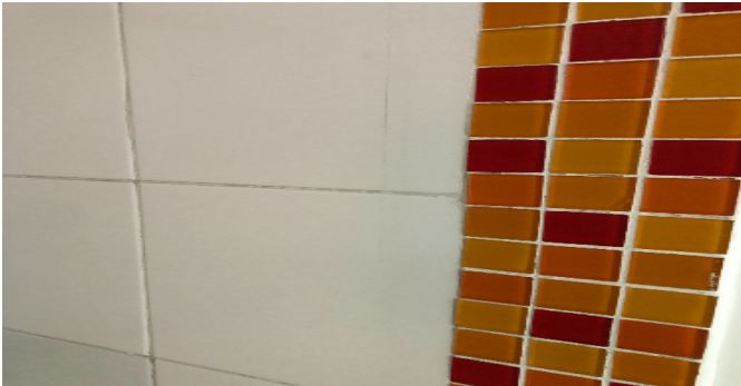
Detalle de acabados
