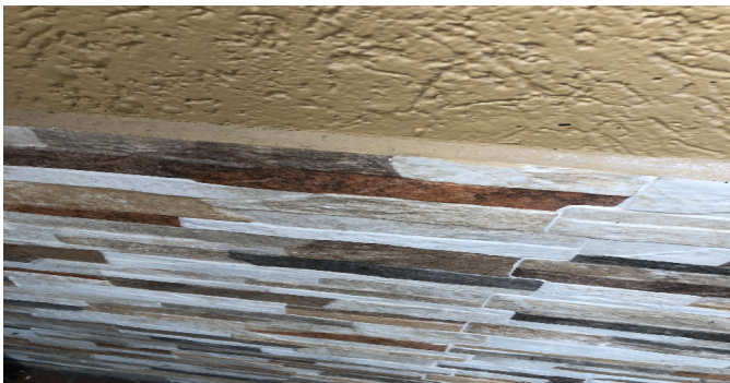
Detalle de acabados
