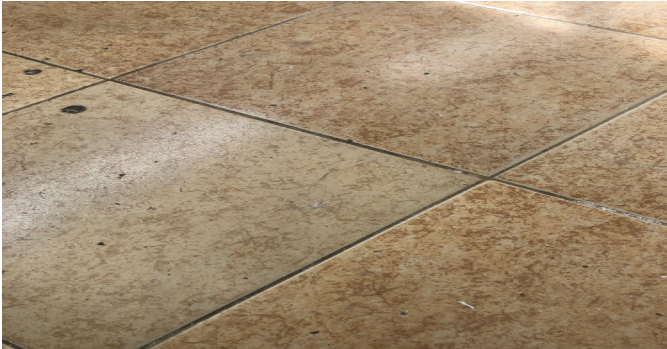
Detalle de acabados
