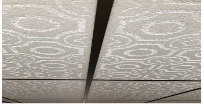
Detalle de acabados
