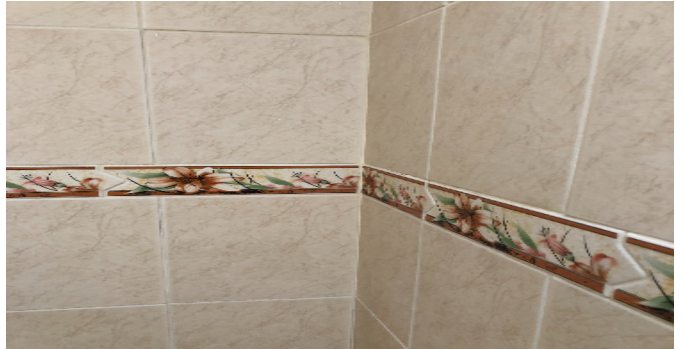
Detalle de acabados
