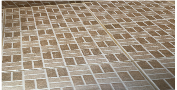
Detalle de acabados
