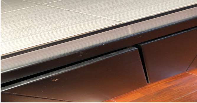
Detalle de acabados
