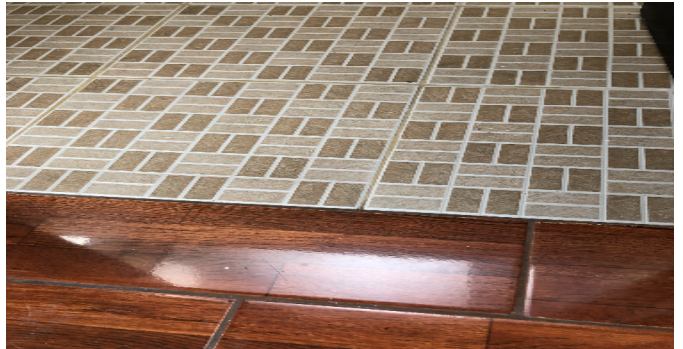
Detalle de acabados
