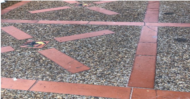
Detalle de acabados
