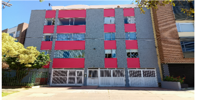
Fachada del Inmueble
