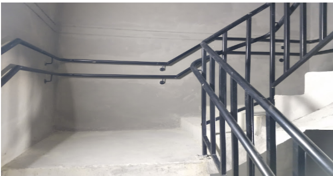
Escalera común - CJ
