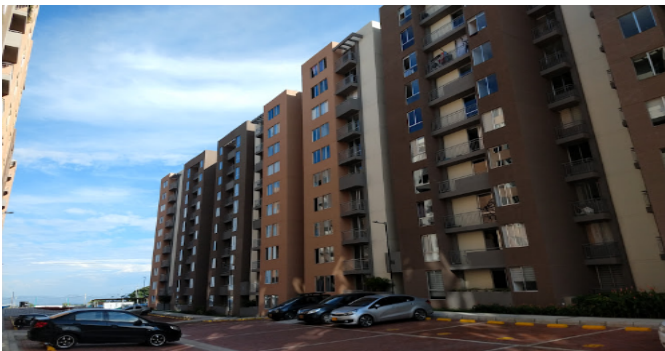
Fachada del Inmueble
