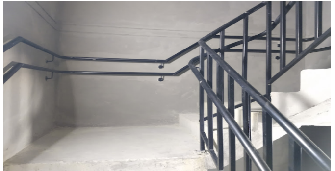
Escalera común - CJ
