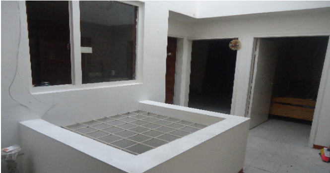
Detalle de acabados
