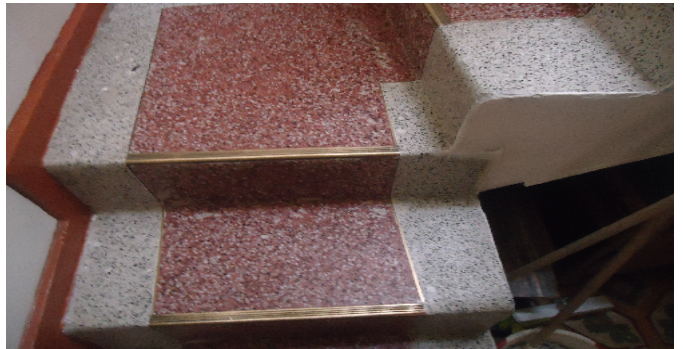
Detalle de acabados
