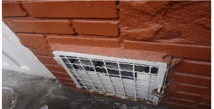
Contador de Gas
